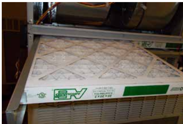
FIGURE 10 Installation du filtre gauche de 2"
