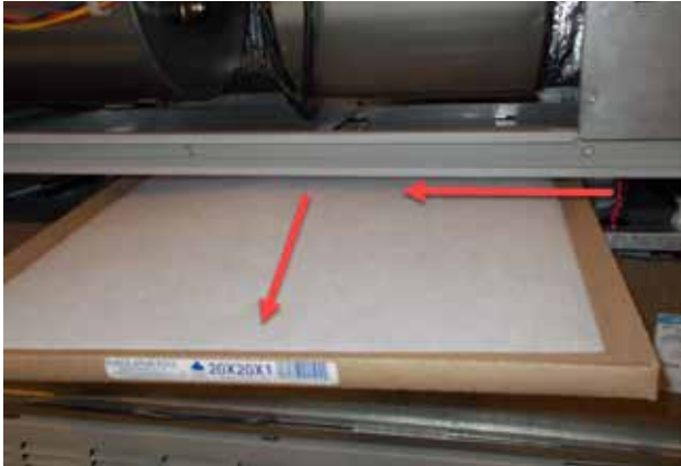
FIGURE 3 Retrait du deuxième filtre
