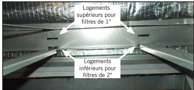
5. Réinstaller les quatre (4) vis dans les trous de vis supérieurs des supports de filtre. Pliez ensuite la languette vers le haut pour l'écarter (Figure 8).
