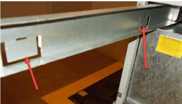
2. Repérer les supports de filtre et retirer les quatre (4) vis qui les maintiennent en haut du panneau de commande (Figure 6).
