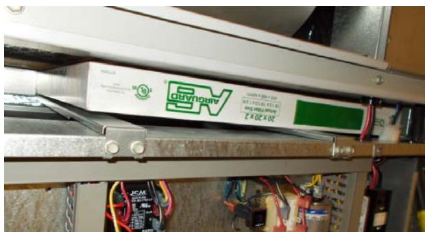
FIGURE 10 Installation du filtre gauche de 2"
