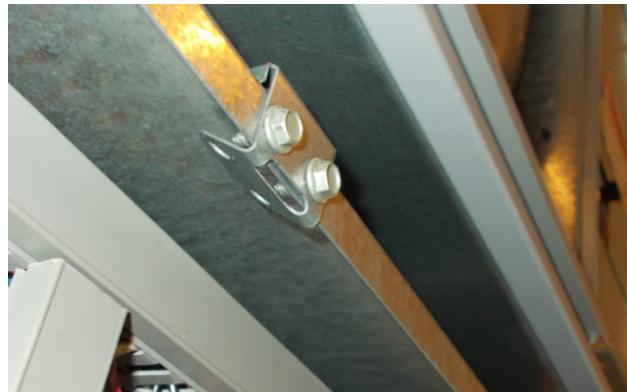
FIGURE 8 Réinstallation des vis et pliage des languettes vers le haut
