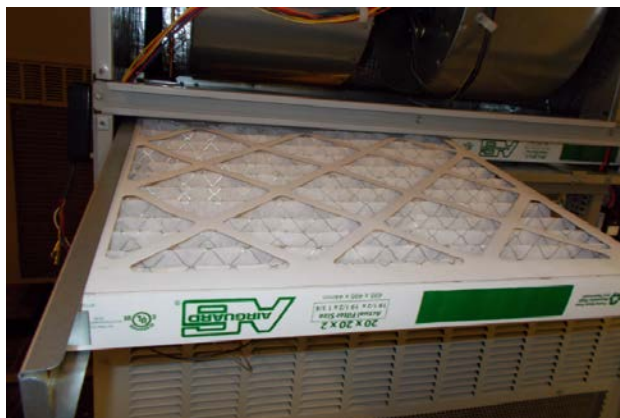
FIGURE 10 Installation du filtre gauche de 2"
