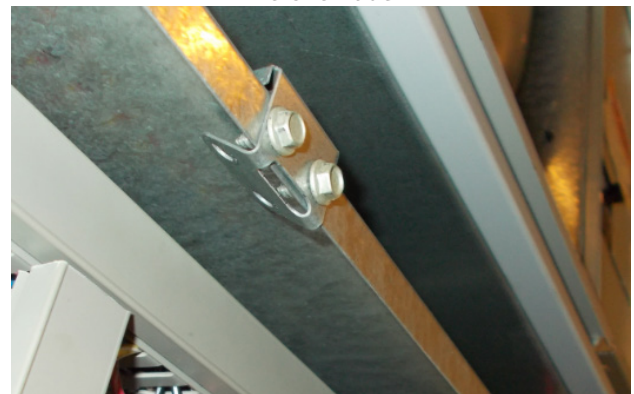
FIGURE 8 Réinstallation des vis et pliage des languettes vers le haut
