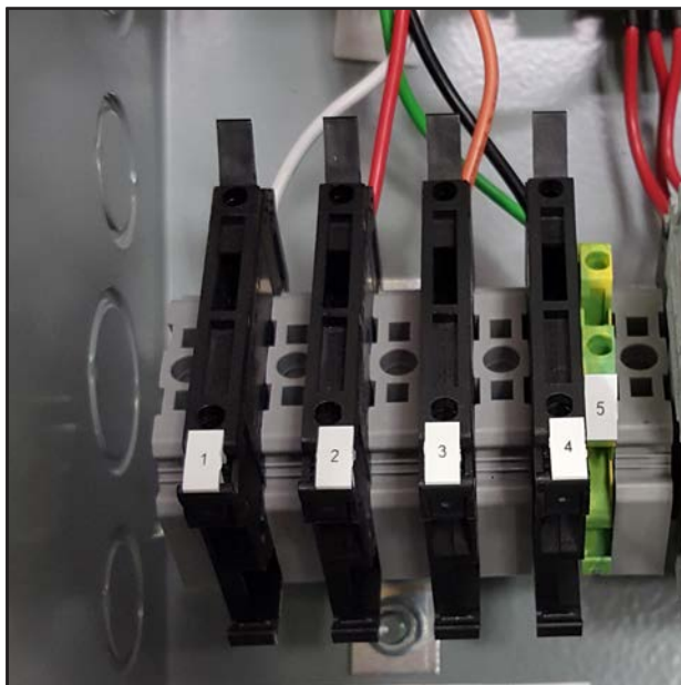
FIGURE 13 Bornes d'alimentation du LC6000 protégées par fusible
