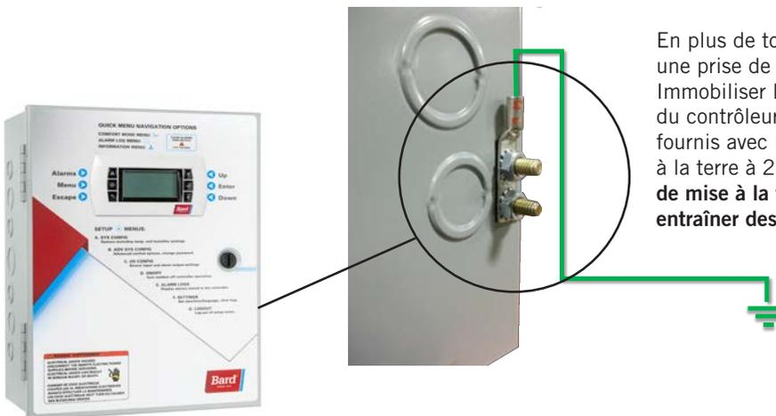
En plus de toute mise à la terre du conduit, une prise de terre efficace doit être raccordée. Immobiliser la mise à la terre sur le côté du boîtier du contrôleur à l'aide des boulons et écrous, fournis avec le contrôleur, et de la cosse de mise à la terre à 2 orifices, fournie sur site. **Tout défaut de mise à la terre du boîtier du contrôleur peut entraîner des dommages à l'équipement.**
