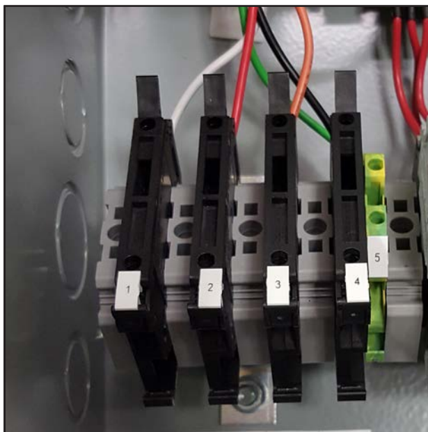
FIGURE 12 Bornes d'alimentation du LC6000 protégées par fusible
