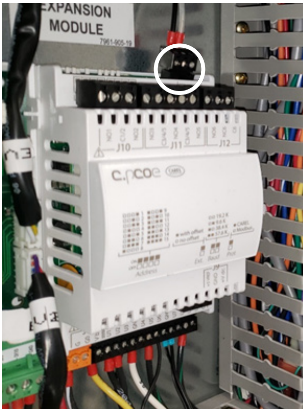
FIGURA 88 Desenchufe Modbus del módulo de expansión
