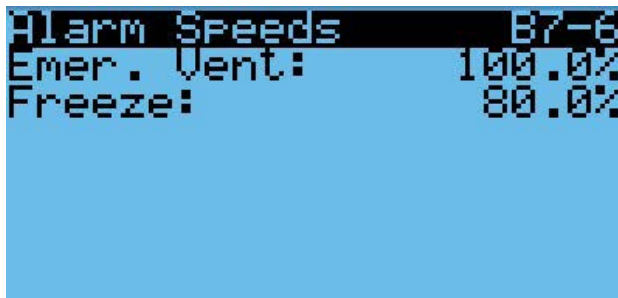
FIGURA 29 Ajuste de las velocidades de ventilación y congelación de emergencia
