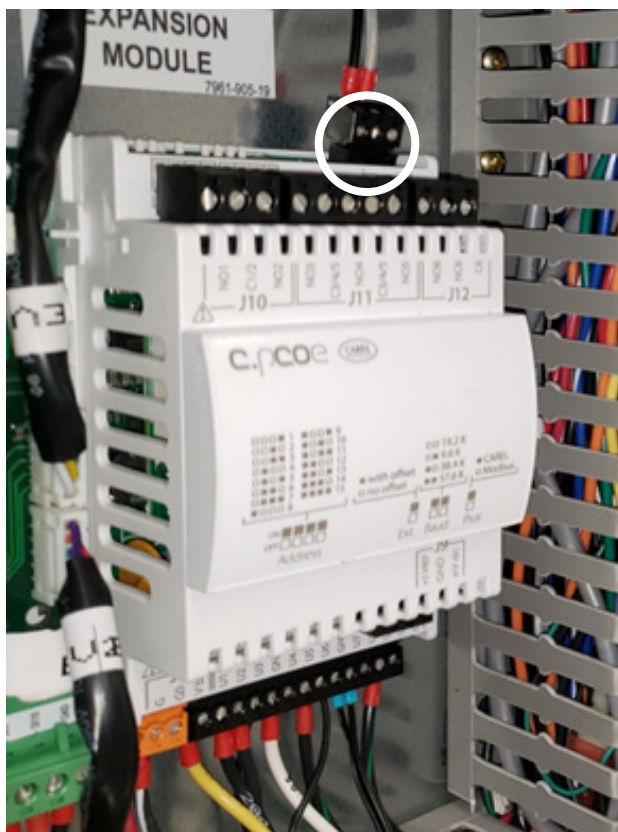
FIGURA 88 Desenchufe Modbus del módulo de expansión
