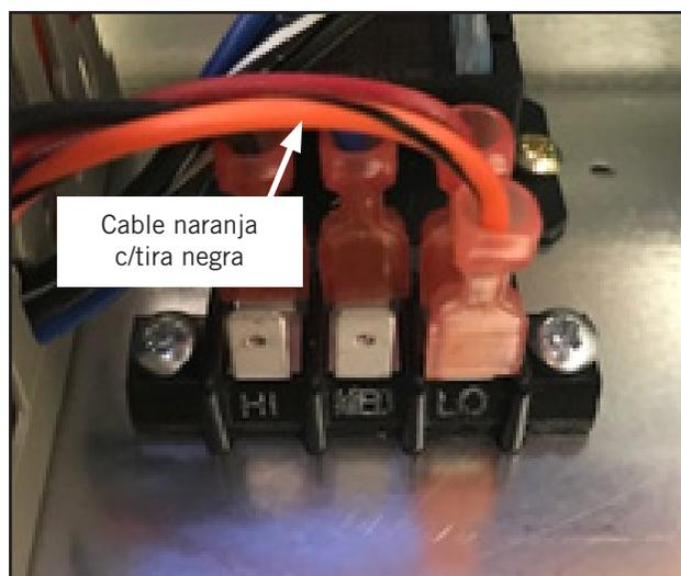
**Toma de velocidad 1: Solo ventilador/soplador**
