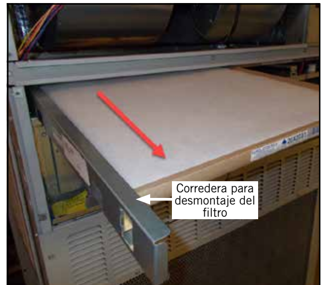
FIGURA 2 Desmontaje del filtro izquierdo
