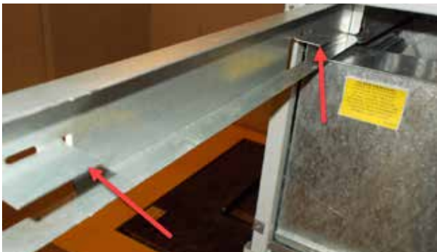
FIGURA 4 Lengüetas del filtro en posición hacia arriba
