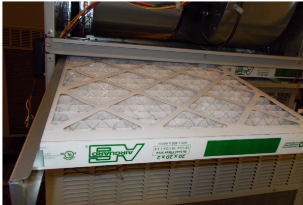
FIGURA 10 Instale el filtro de 2" izquierdo
