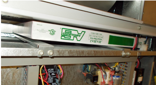
FIGURA 10 Instale el filtro de 2" izquierdo
