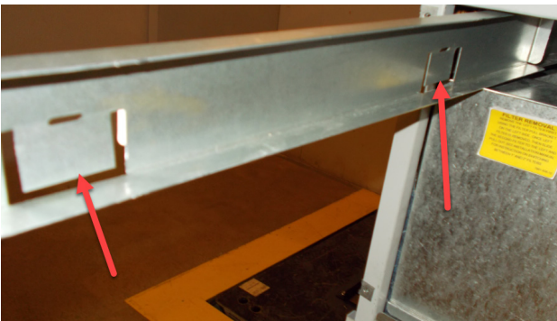
FIGURA 5 Doble las lengüetas del filtro hacia abajo
