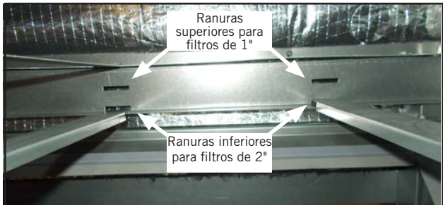
FIGURA 7 Vuelva a instalar los soportes de soporte del filtro en las ranuras inferiores
