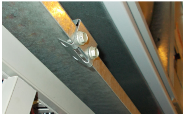
FIGURA 8 Vuelva a colocar los tornillos y doble las lengüetas hacia arriba
