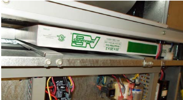
FIGURA 10 Instale el filtro de 2" izquierdo
