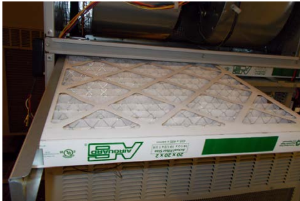
FIGURA 10 Instale el filtro de 2" izquierdo
