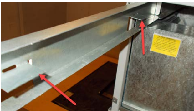
FIGURA 5 Doble las lengüetas del filtro hacia abajo
