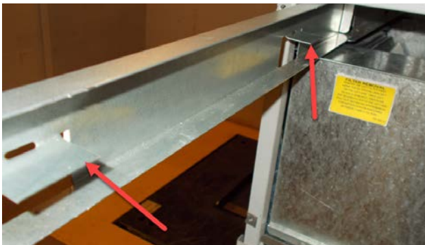
FIGURA 5 Doble las lengüetas del filtro hacia abajo
