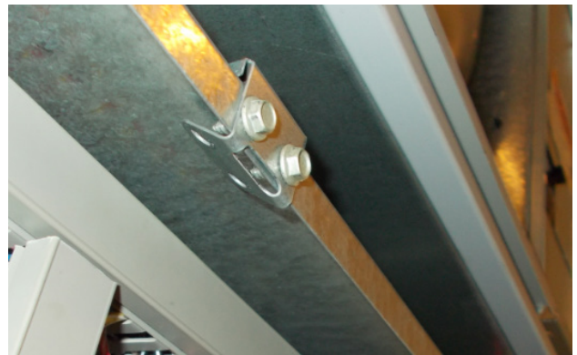
FIGURA 8 Vuelva a colocar los tornillos y doble las lengüetas hacia arriba
