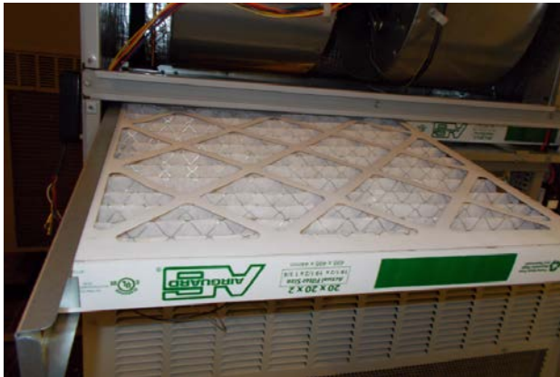
FIGURA 10 Instale el filtro de 2" izquierdo
