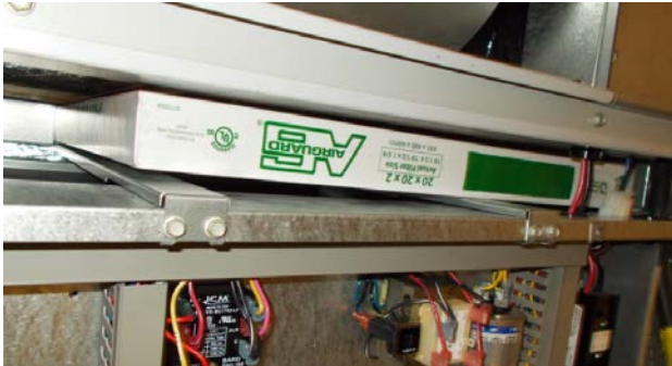
FIGURA 10 Instale el filtro de 2" izquierdo
