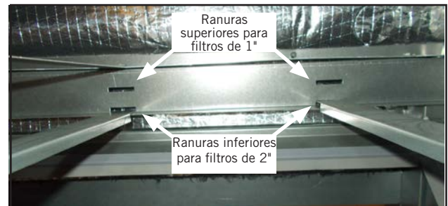
FIGURA 7 Vuelva a instalar los soportes de soporte del filtro en las ranuras inferiores
