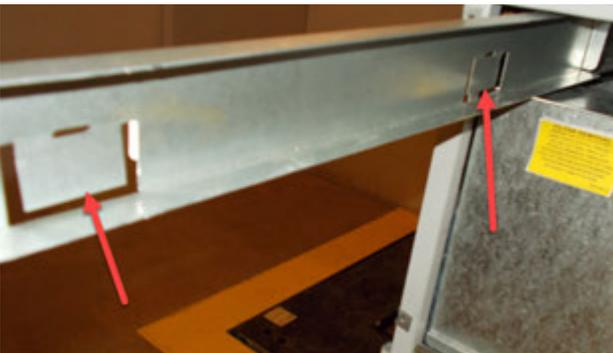
2. Ubique los soportes del filtro y retire los cuatro (4) tornillos que los sujetan a la parte superior del panel de control (vea la Figura 6).
