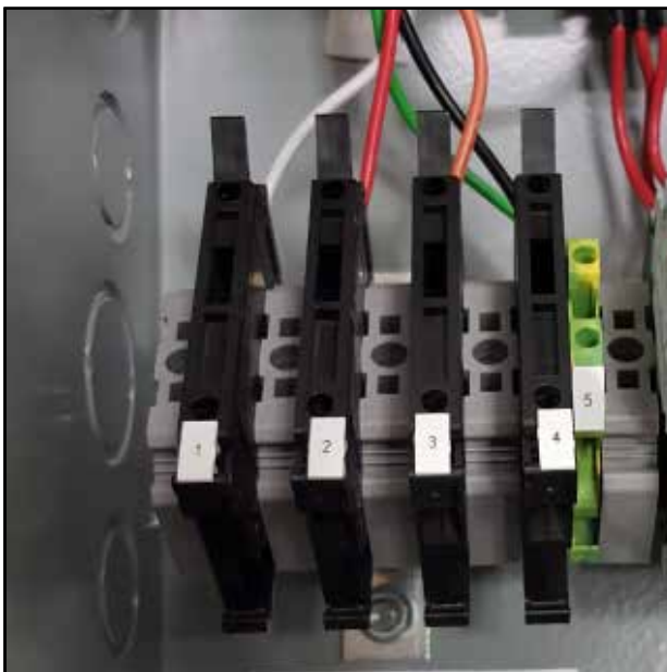
FIGURA 15 Bornes portafusibles de la alimentación del LC6000
