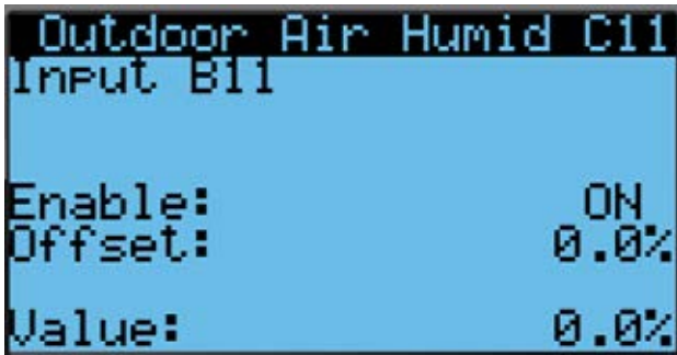
FIGURA 43 Habilitar/inhabilitar sensor de humedad del aire exterior
